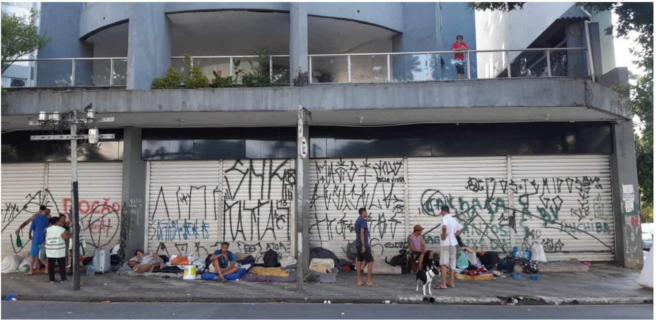
Moradores de rua que ocupam quarteirão rua próxima ao Hospital Pérola Byington — Foto: Bárbara Muniz Vieira/G1
